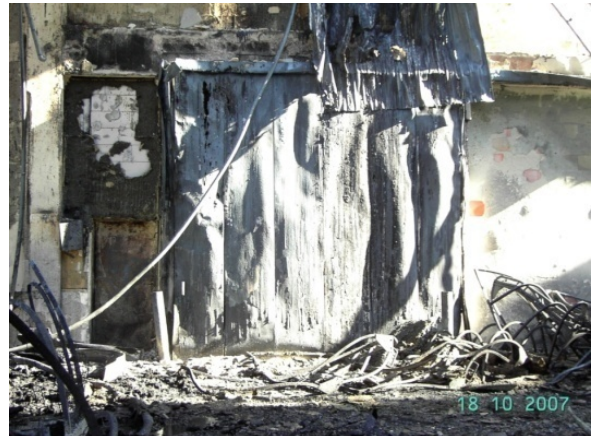
Rysunek 2 – Brama MARC-P po pożarze, widok od strony działania ognia
